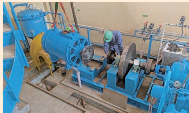
(下野沢揚水機場ポンプ・モーター補修機材搬入・据付工事)
